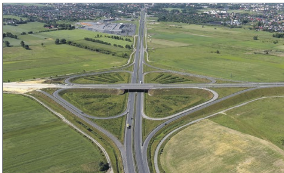
Dokumenty przygotowane przez planistów wskazują np. gdzie powinna przebiegać droga (na zdjęciu węzeł nieopodal Ostrowa Wielkopolskiego).
