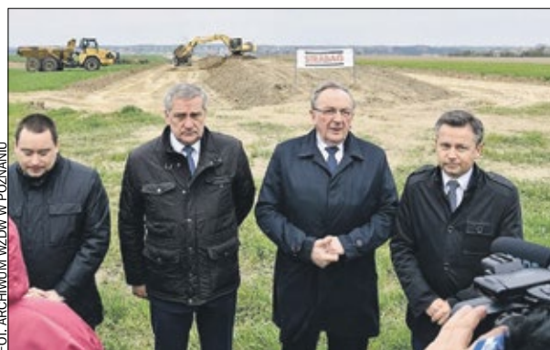
9 kwietnia plac budowy symbolicznie przekazano wykonawcy prac.
