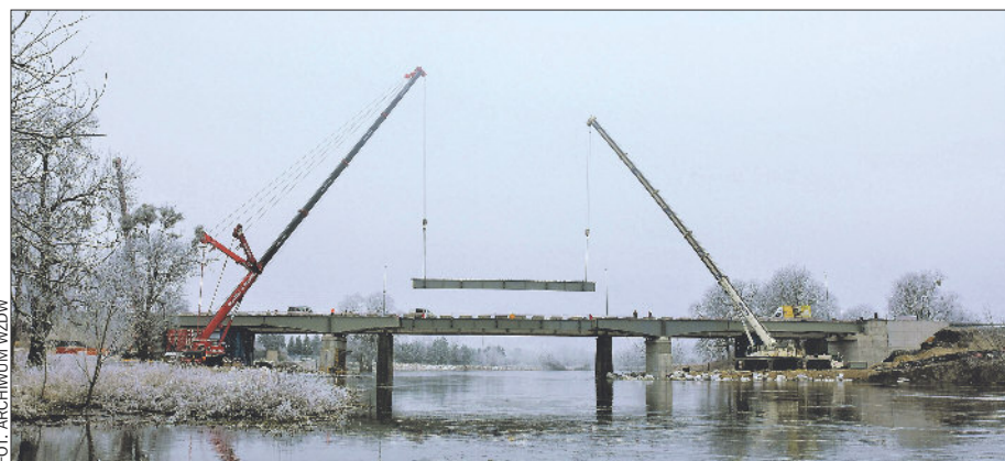
Montaż środkowego przęsła mostu pozwolił połączyć dwa brzegi rzeki.
