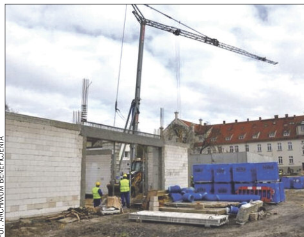
Trwają prace budowlane, aby jeszcze w tym roku obiekt w Ostrowie Wilkp. mógł służyć uczniom.
