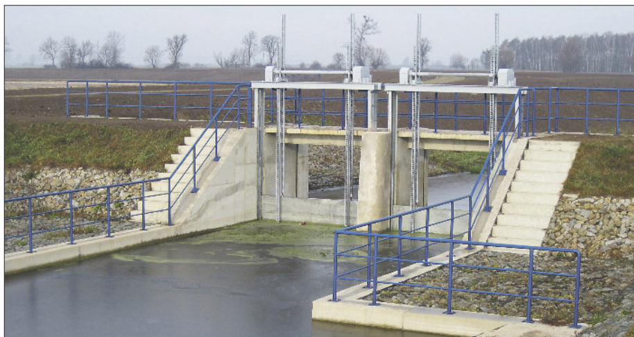
Budowa akwenów to widowiskowe przedsięwzięcia, ale również duże znaczenie dla gospodarki wodnej w regionie mała retencja.
